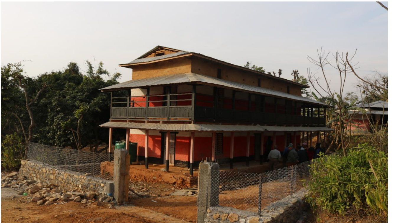
पालुङटारमा बनिरहेको कुमाल संग्रहालय भवन
