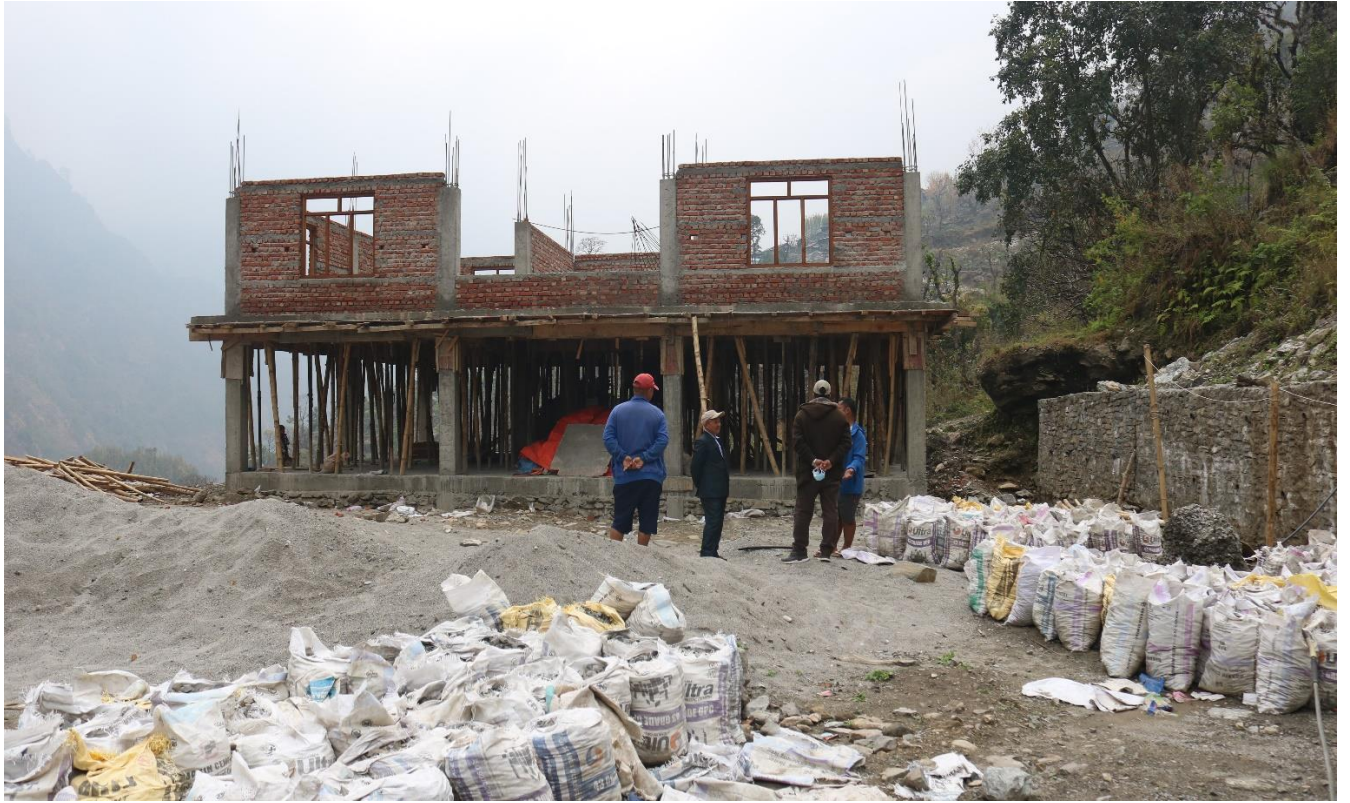
प्रभात किराण मा वि धार्चेमा निर्माणधिन आवासिय भवन
